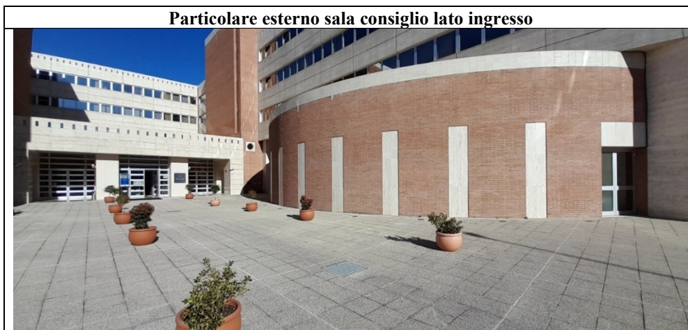
Figura 4. Situazione attuale del fabbricato
