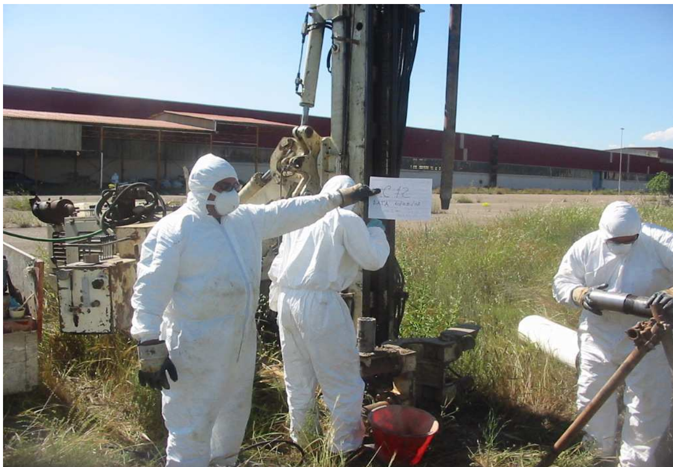
Sondaggio n° C12 Postazione Macchina Operatrice
