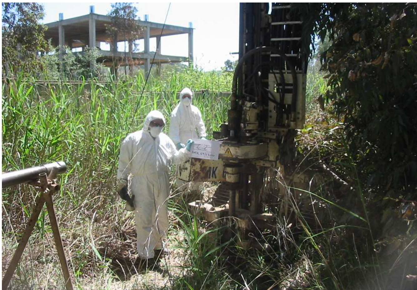
Sondaggio n° C2 Postazione Macchina Operatrice
