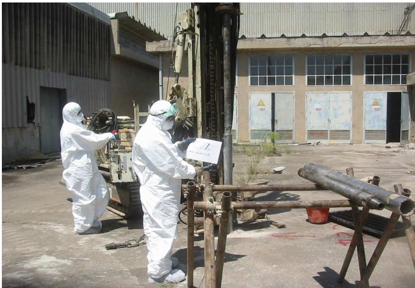
Sondaggio n° C24 Postazione Macchina Operatrice
