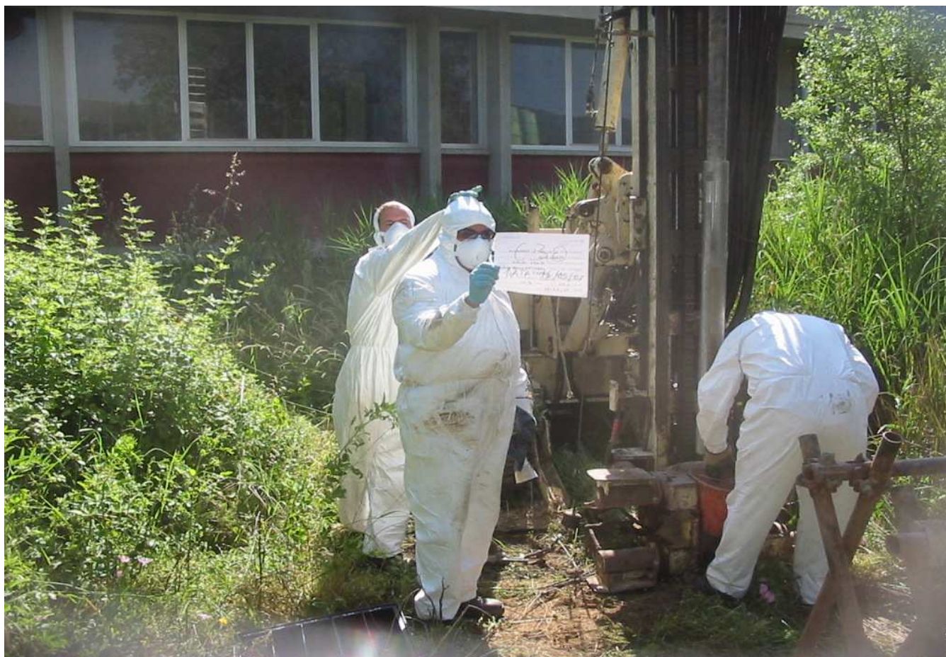
Sondaggio n° C30 Postazione Macchina Operatrice
