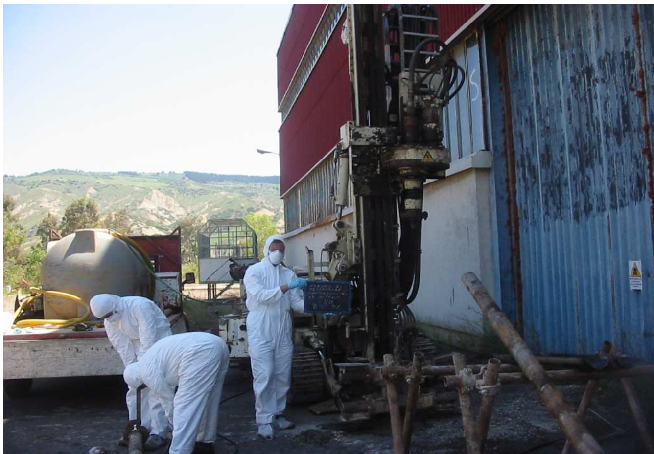
Sondaggio n° C20 Postazione Macchina Operatrice
