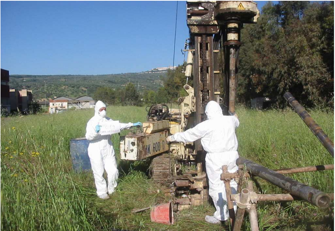
Sondaggio n° C19 Postazione Macchina Operatrice
