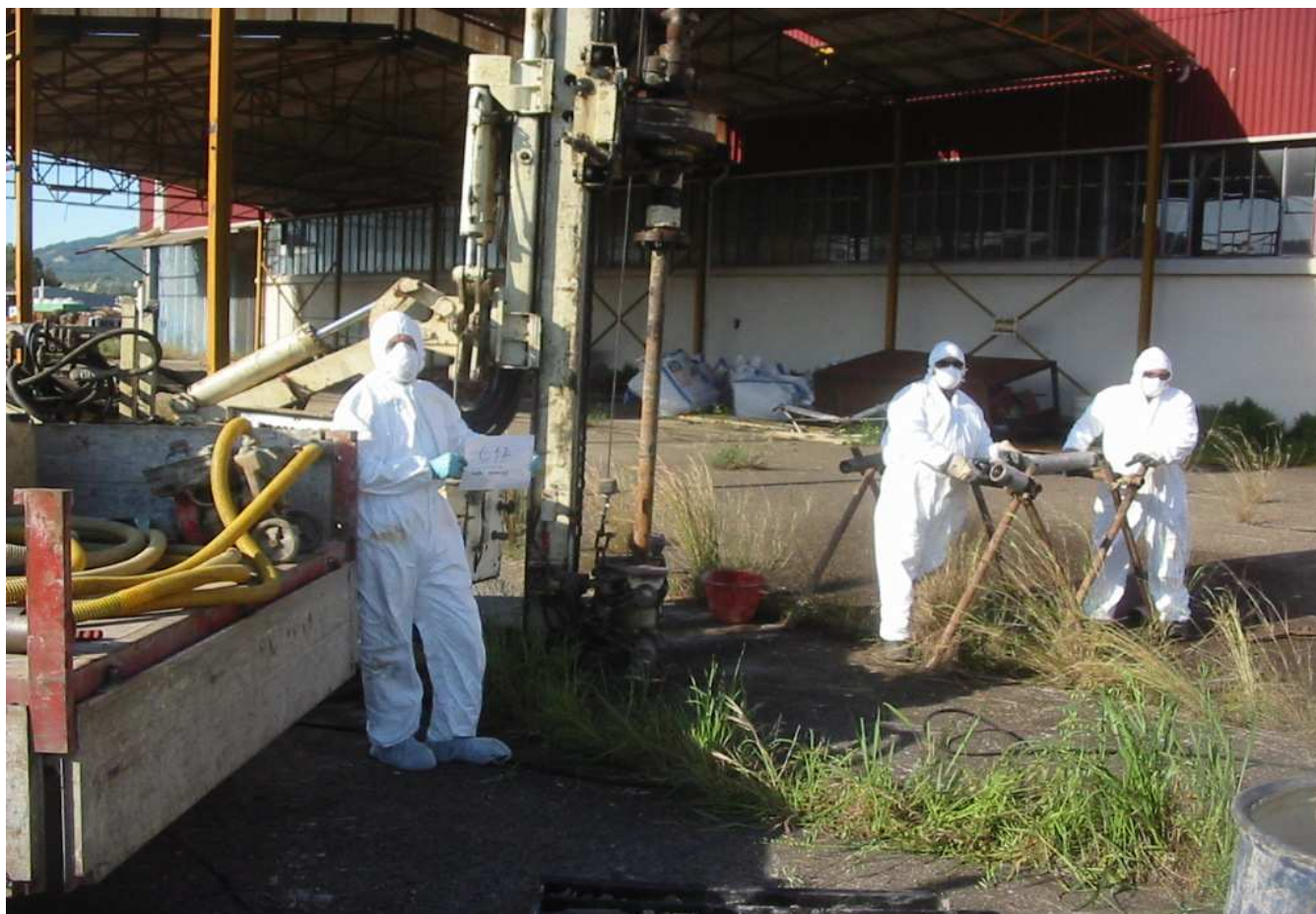
Sondaggio n° C17 Postazione Macchina Operatrice
