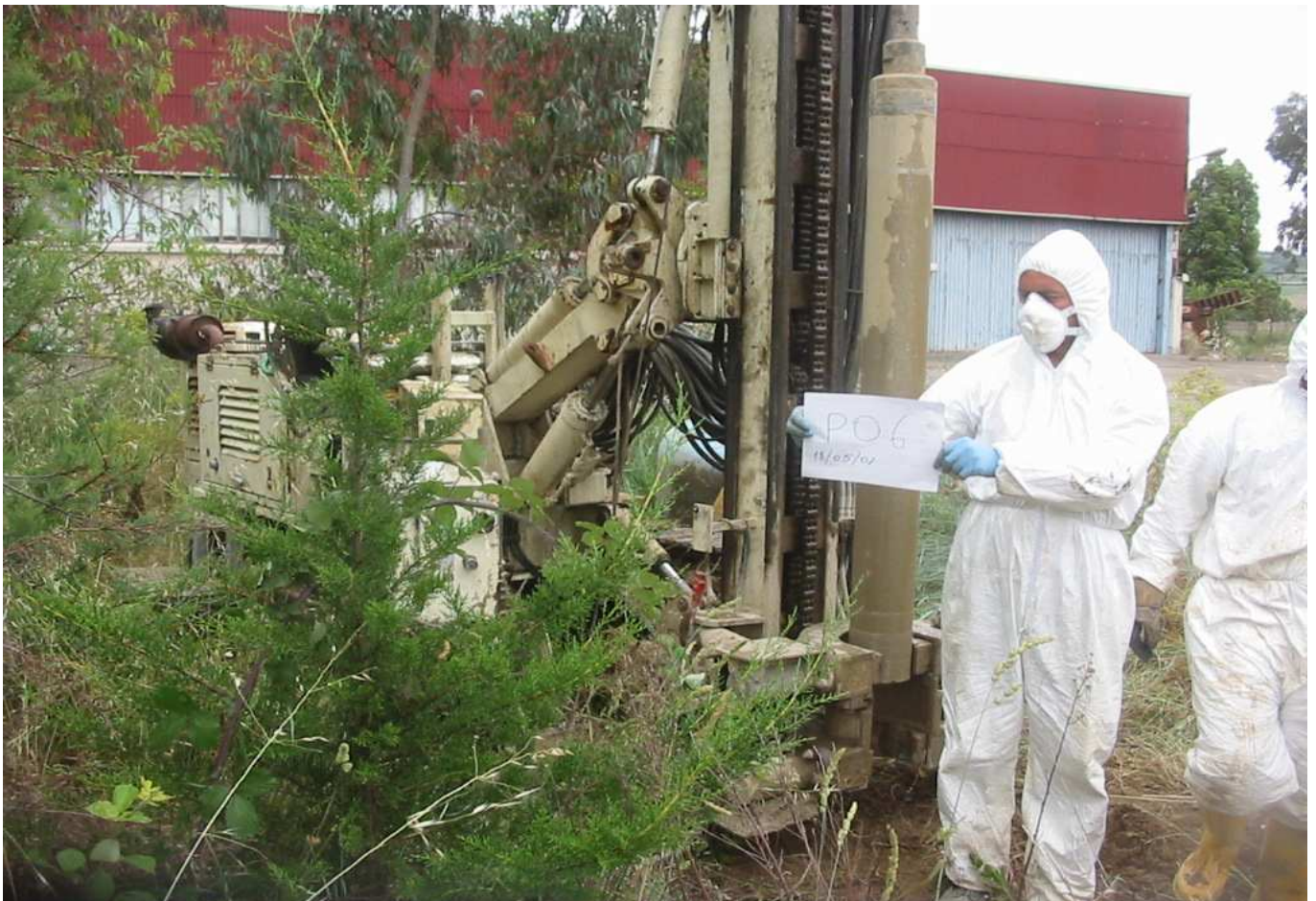
Sondaggio n° P06 Postazione Macchina Operatrice
