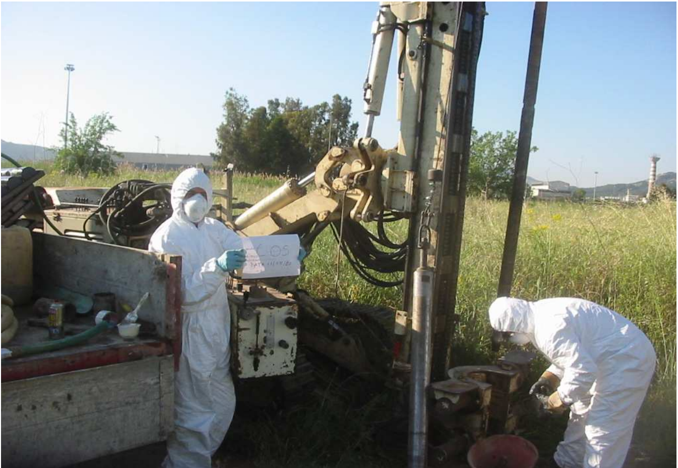
Sondaggio n° C5 Postazione Macchina Operatrice
