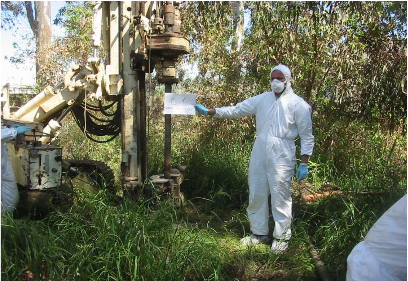
Sondaggio n° C1 Postazione Macchina Operatrice
