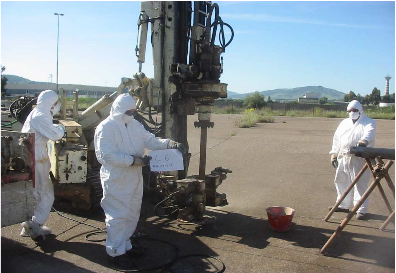
Sondaggio n° C6 Postazione Macchina Operatrice
