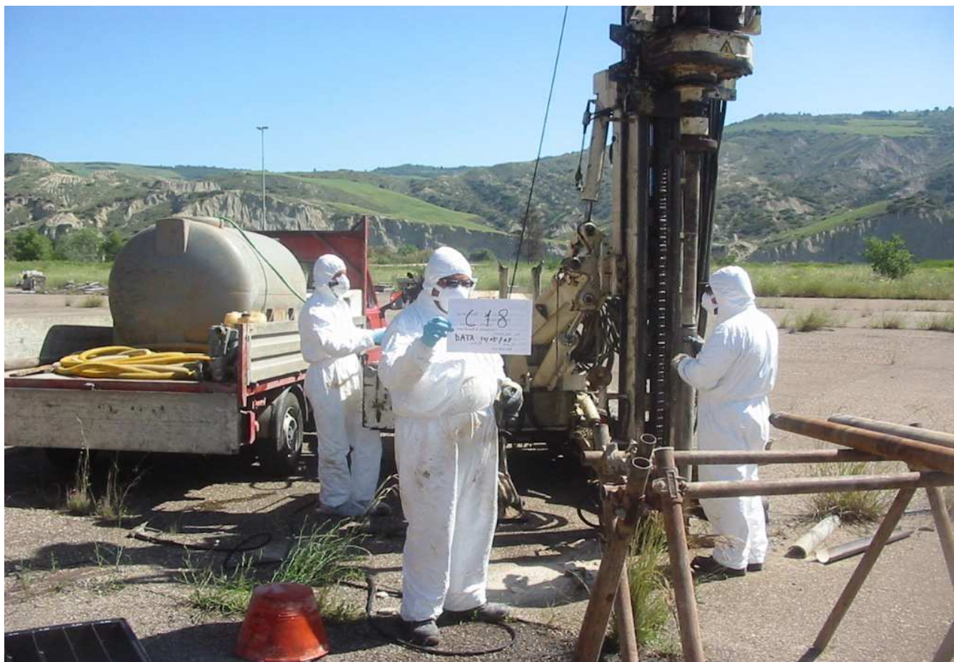
Sondaggio n° C18 Postazione Macchina Operatrice
