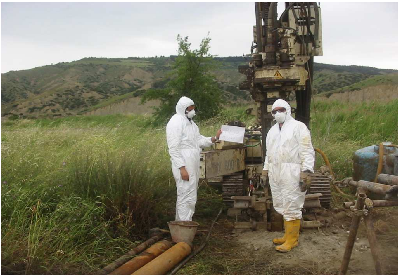
Sondaggio n° P02 Postazione Macchina Operatrice
