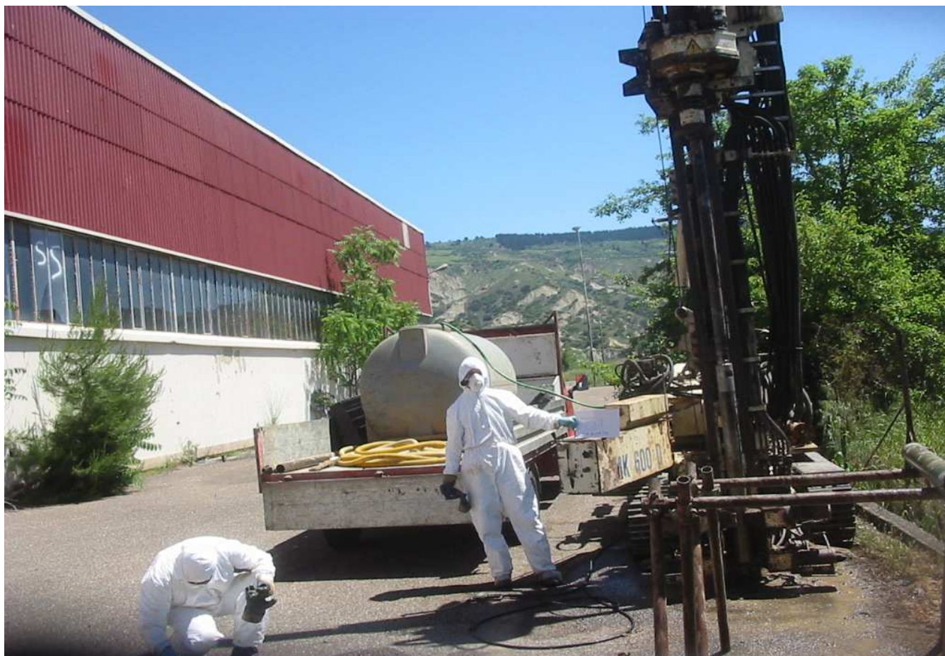
Sondaggio n° C21 Postazione Macchina Operatrice
