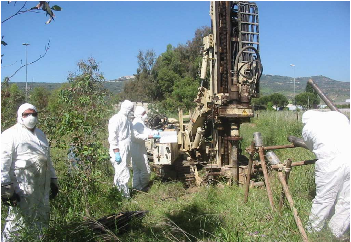
Sondaggio n° C7 Postazione Macchina Operatrice
