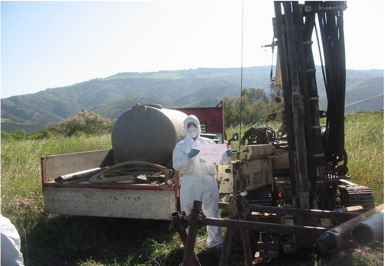
Sondaggio n° C10 Postazione Macchina Operatrice
