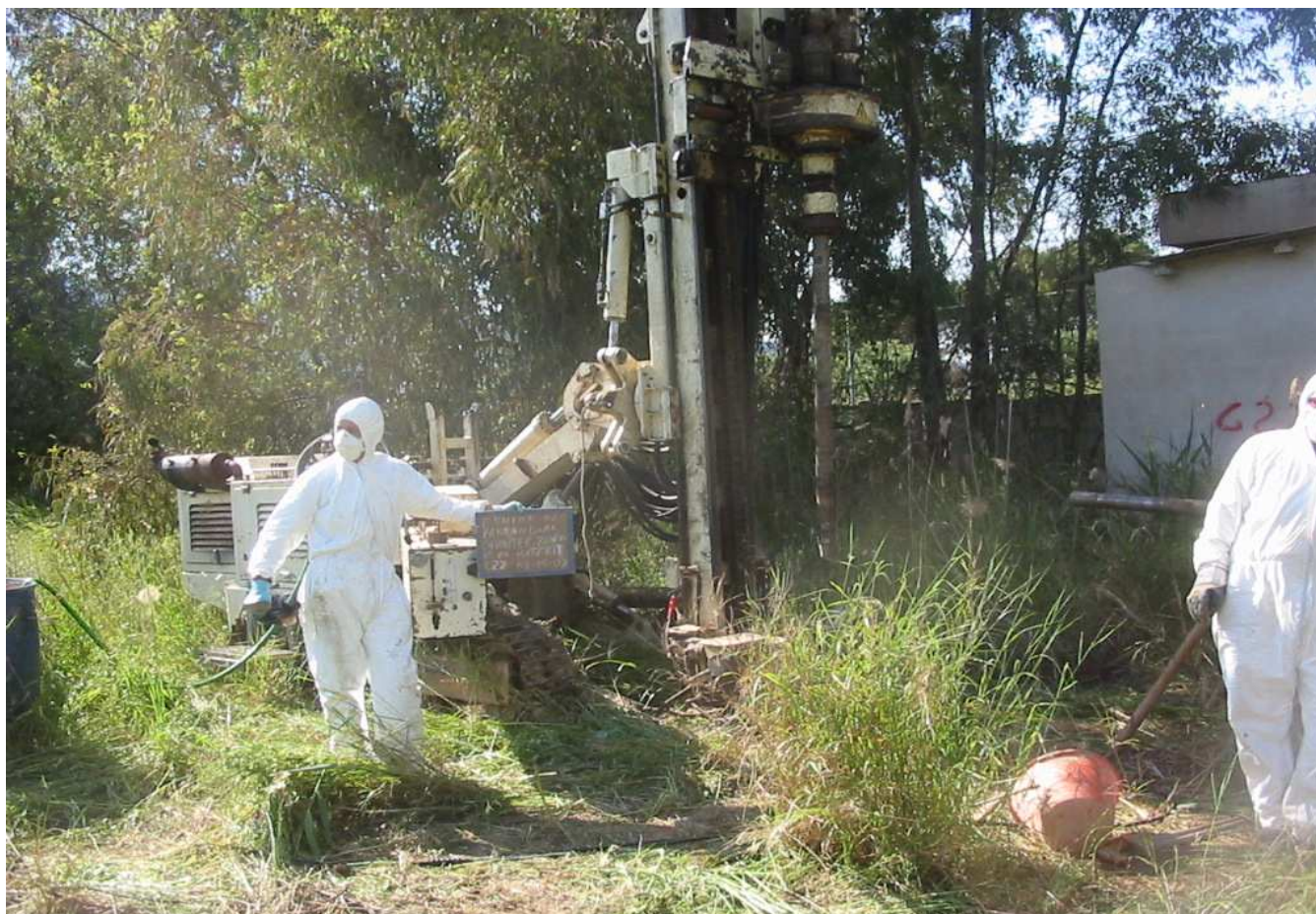
Sondaggio n° C22 Postazione Macchina Operatrice
