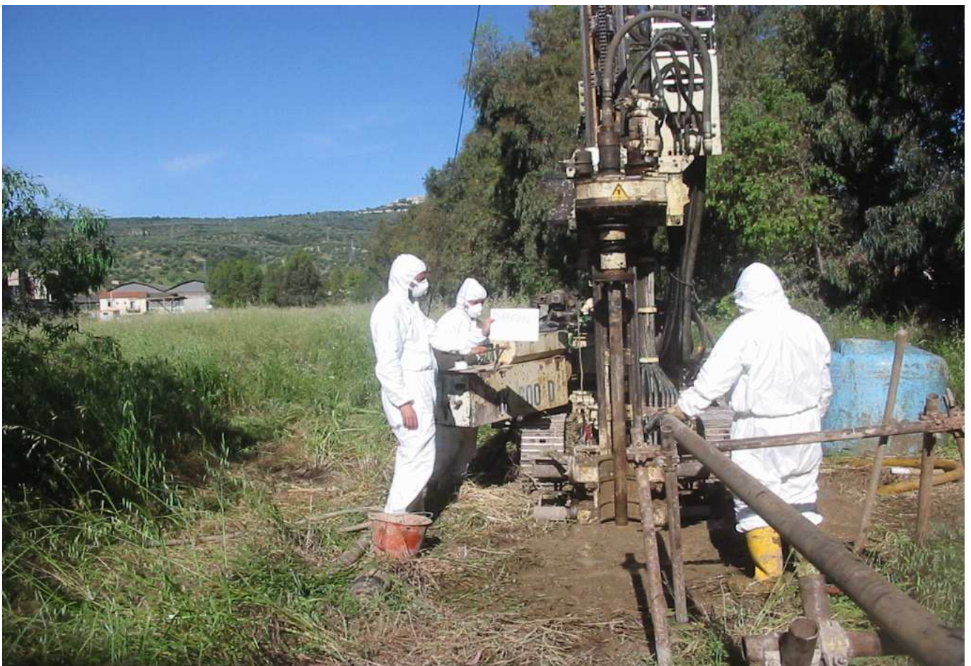
Sondaggio n° P04 Postazione Macchina Operatrice
