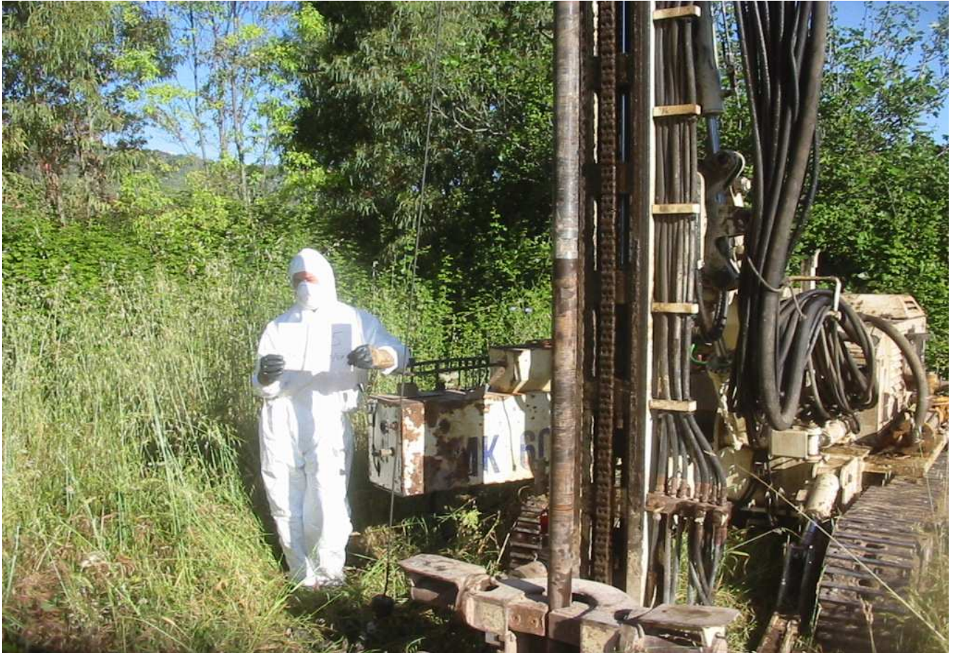
Sondaggio n° P05 Postazione Macchina Operatrice
