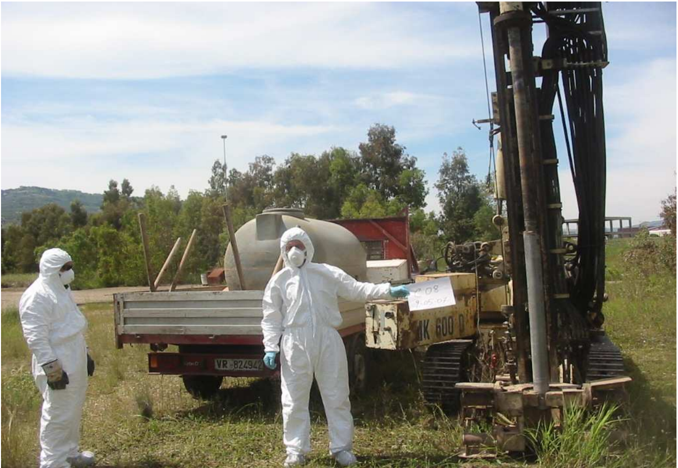
Sondaggio n° C8 Postazione Macchina Operatrice
