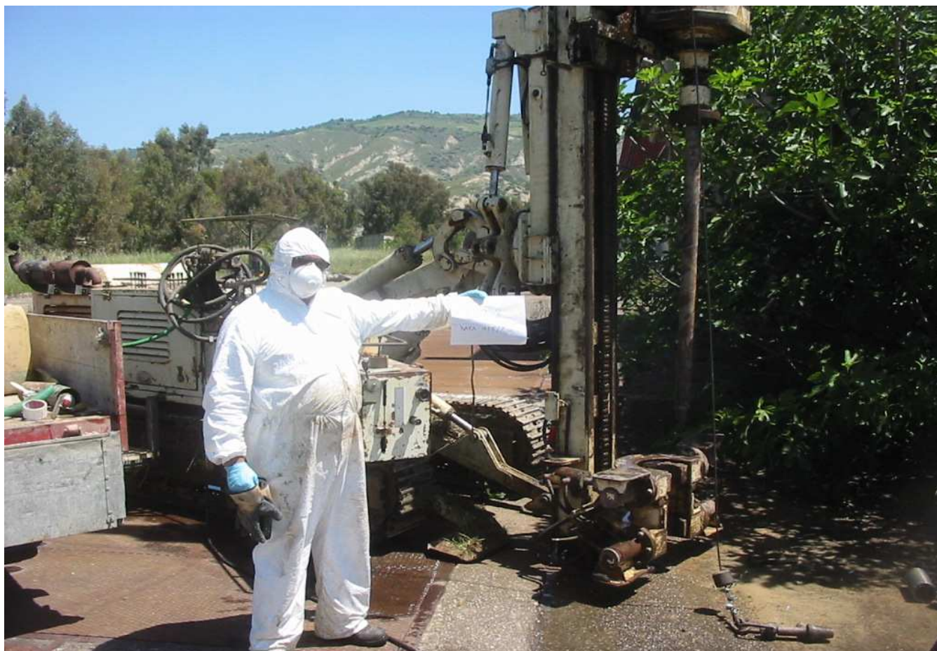
Sondaggio n° C28 Postazione Macchina Operatrice
