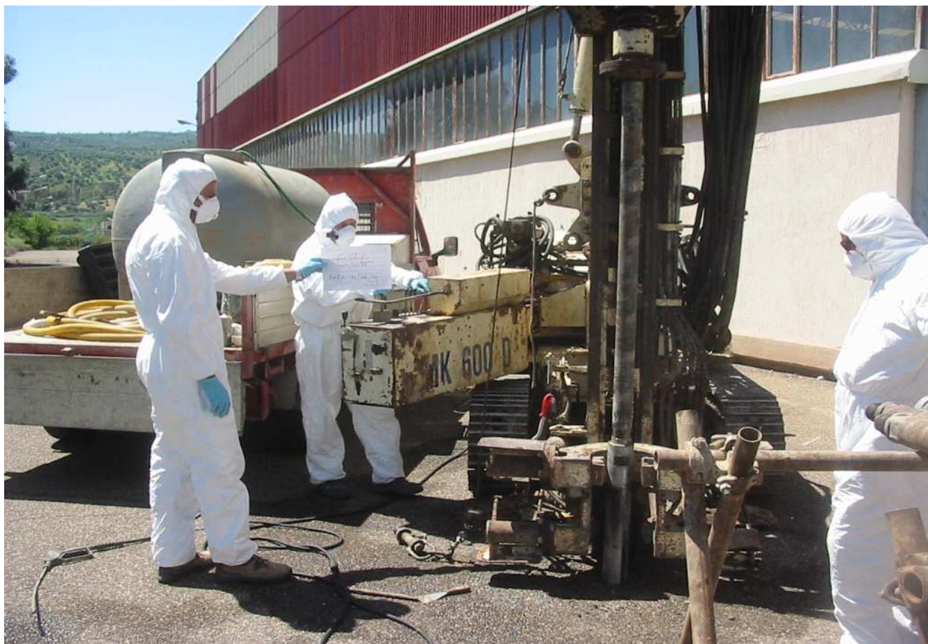
Sondaggio n° C26 Postazione Macchina Operatrice
