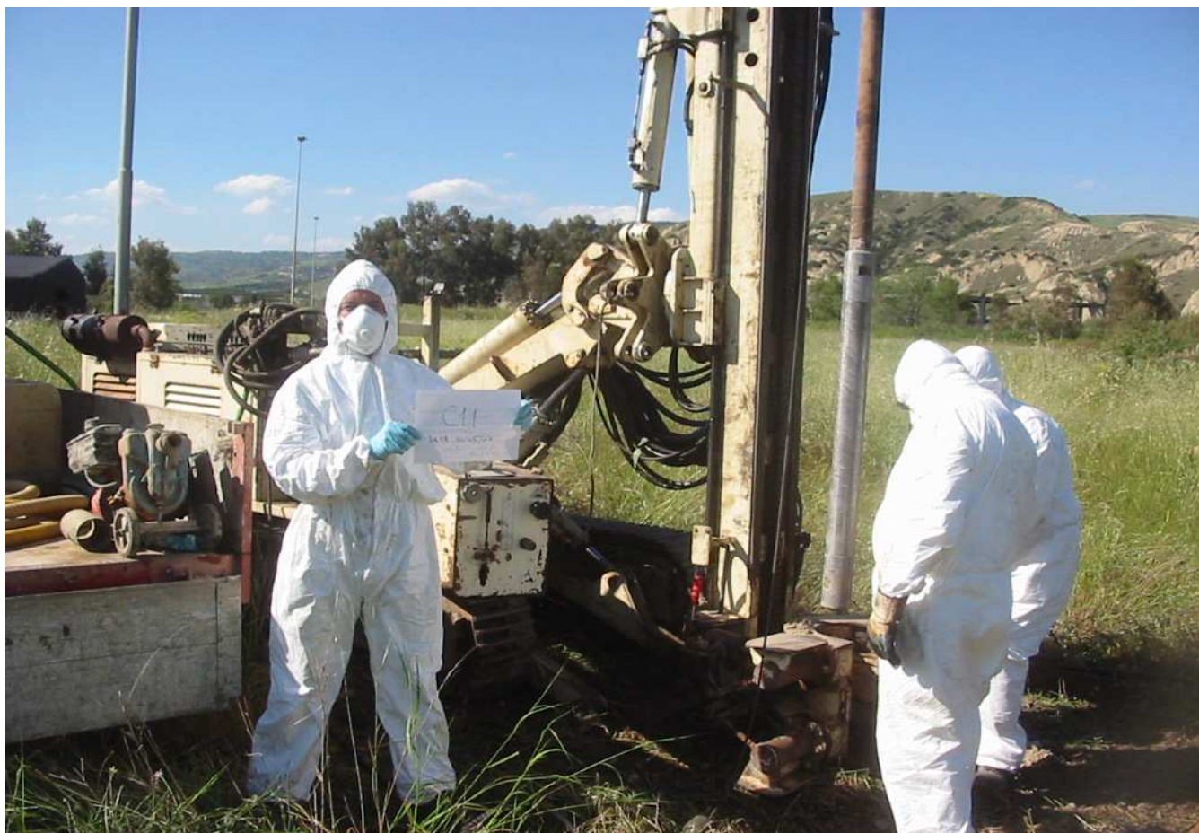
Sondaggio n° C11 Postazione Macchina Operatrice
