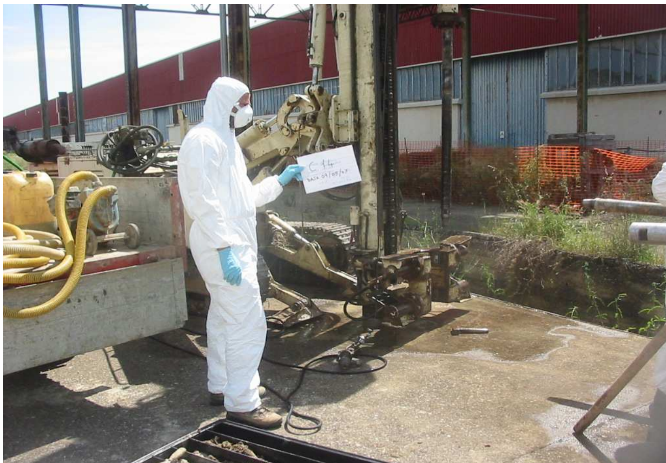
Sondaggio n° C14 Postazione Macchina Operatrice
