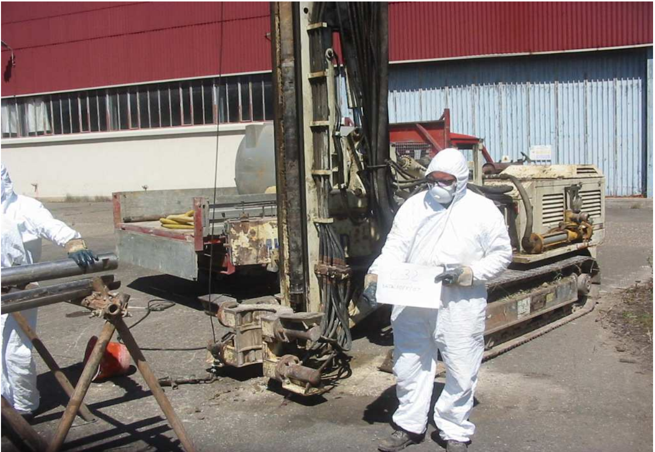
Sondaggio n° C32 Postazione Macchina Operatrice
