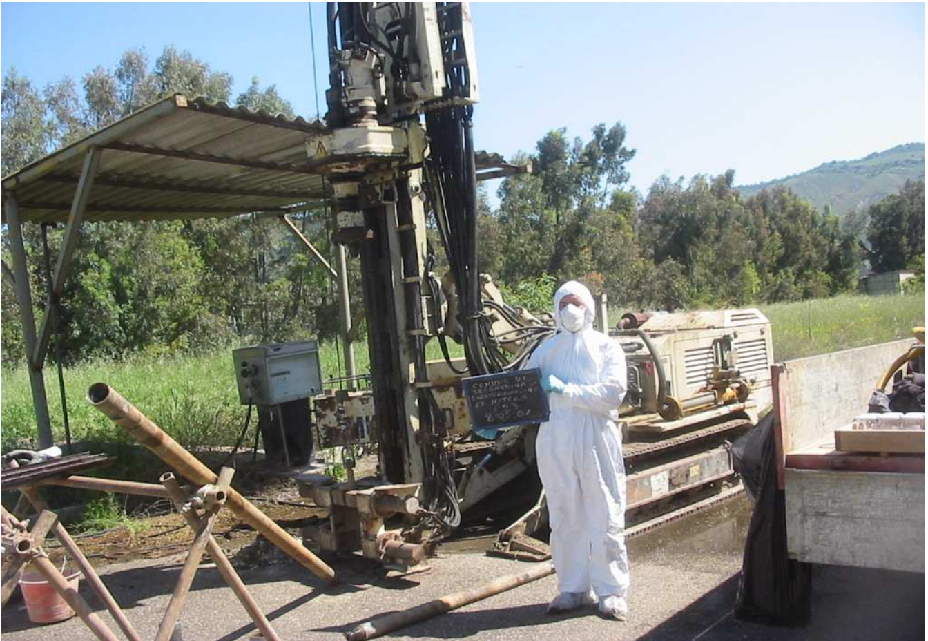
Sondaggio n° C23 Postazione Macchina Operatrice
