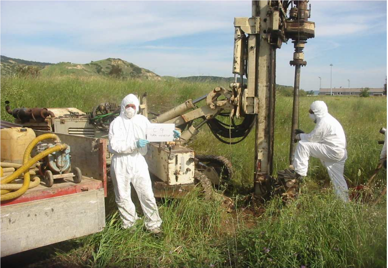
Sondaggio n° C9 Postazione Macchina Operatrice
