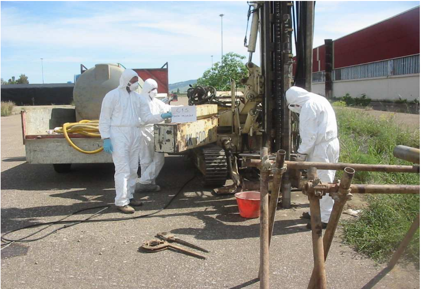
Sondaggio n° C15 Postazione Macchina Operatrice
