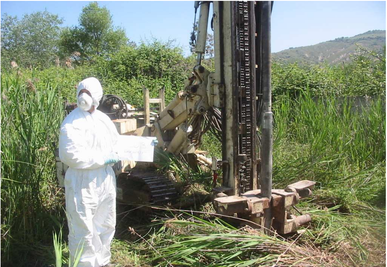
Sondaggio n° C3 Postazione Macchina Operatrice
