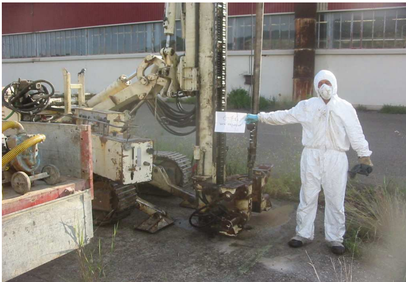
Sondaggio n° C16 Postazione Macchina Operatrice
