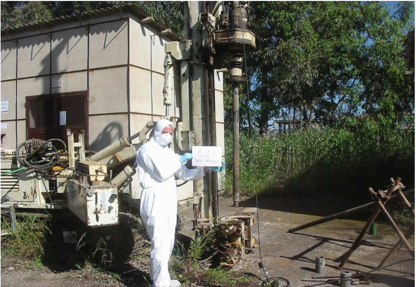
Sondaggio n° C13 Postazione Macchina Operatrice
