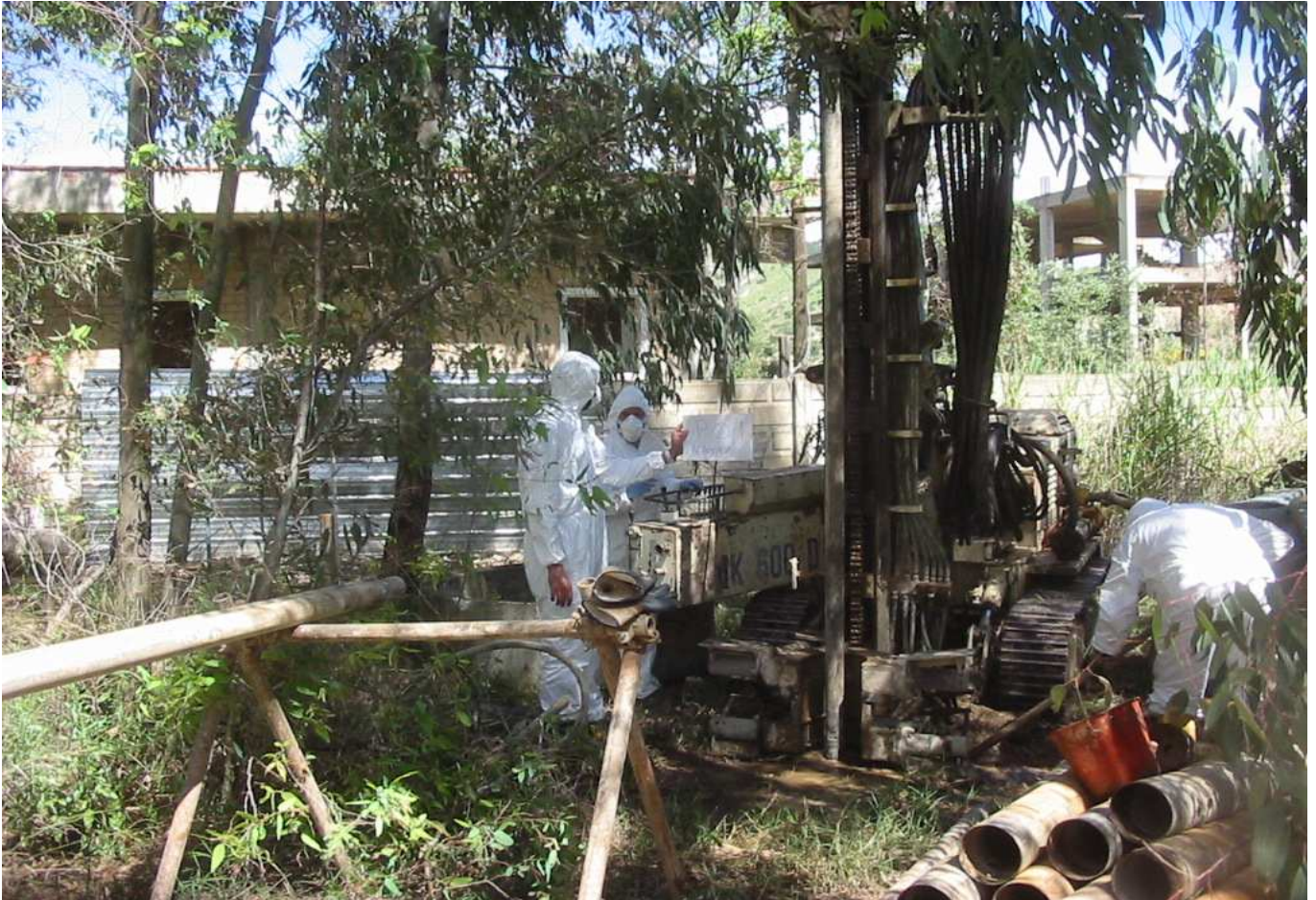
Sondaggio n° P01 Postazione Macchina Operatrice
