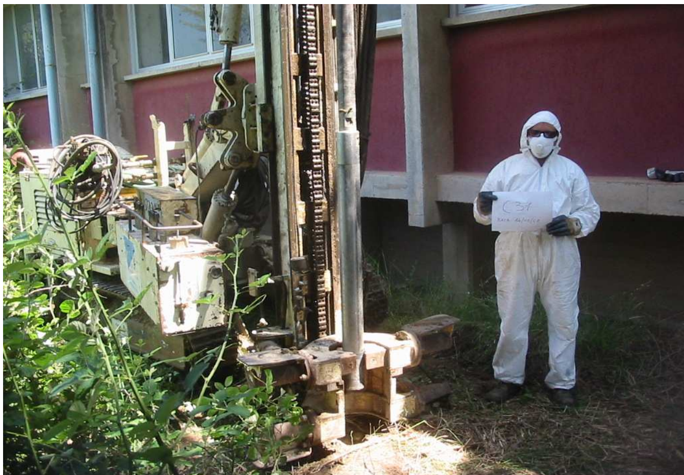
Sondaggio n° C31 Postazione Macchina Operatrice
