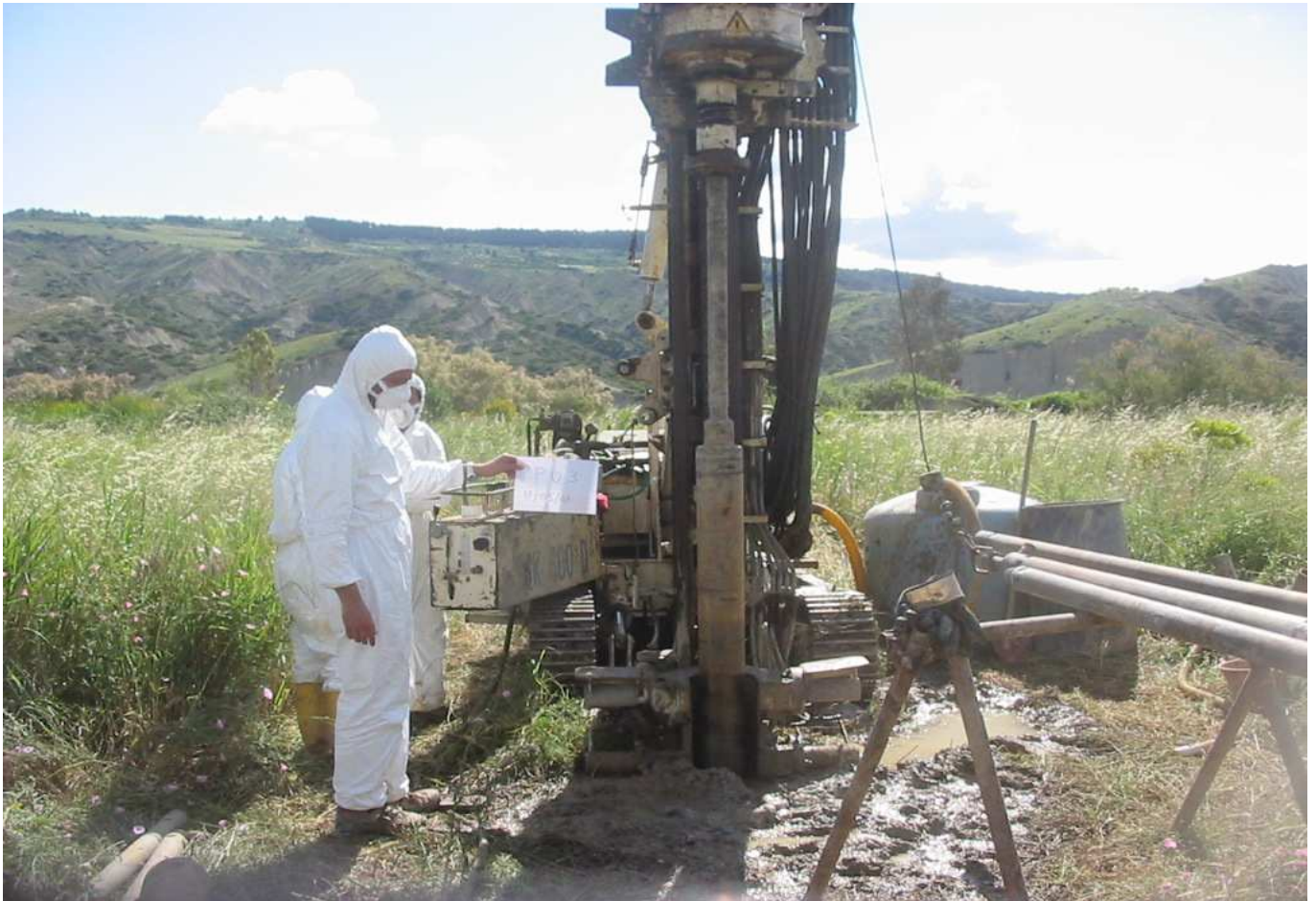
Sondaggio n° P03 Postazione Macchina Operatrice
