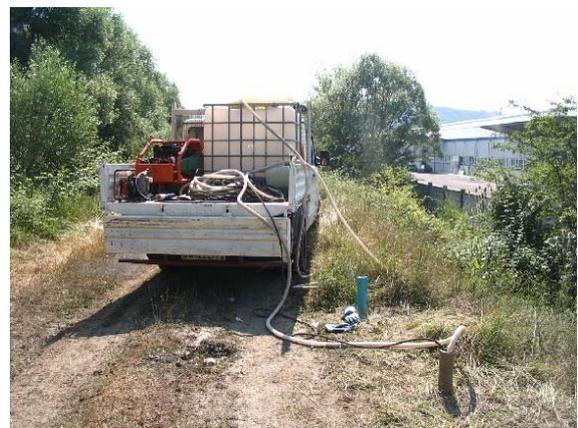
**Fig. 5** – Operazione di spurgo del piezometro.
